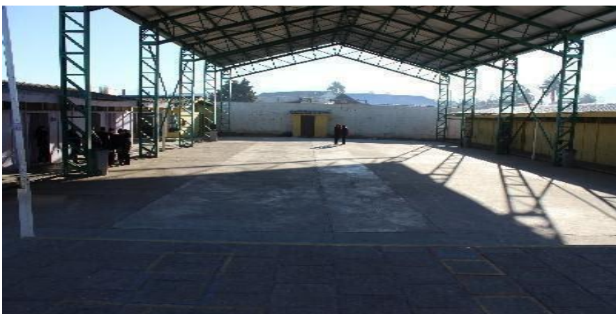
Escalera de evacuación 2° piso para Oficinas y 5° Básico
